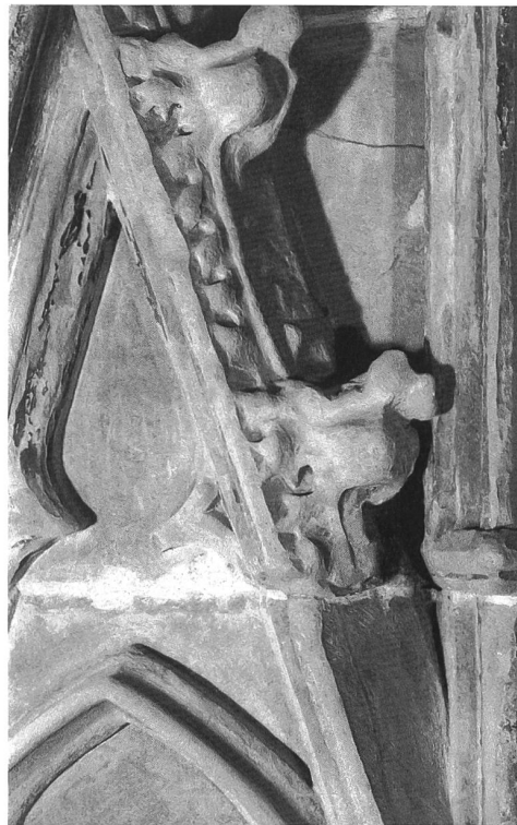
Fig. 76 Détail du décor sculpté de la paroi nord du porche, montrant que les gables et les pinacles sont rapportés.
