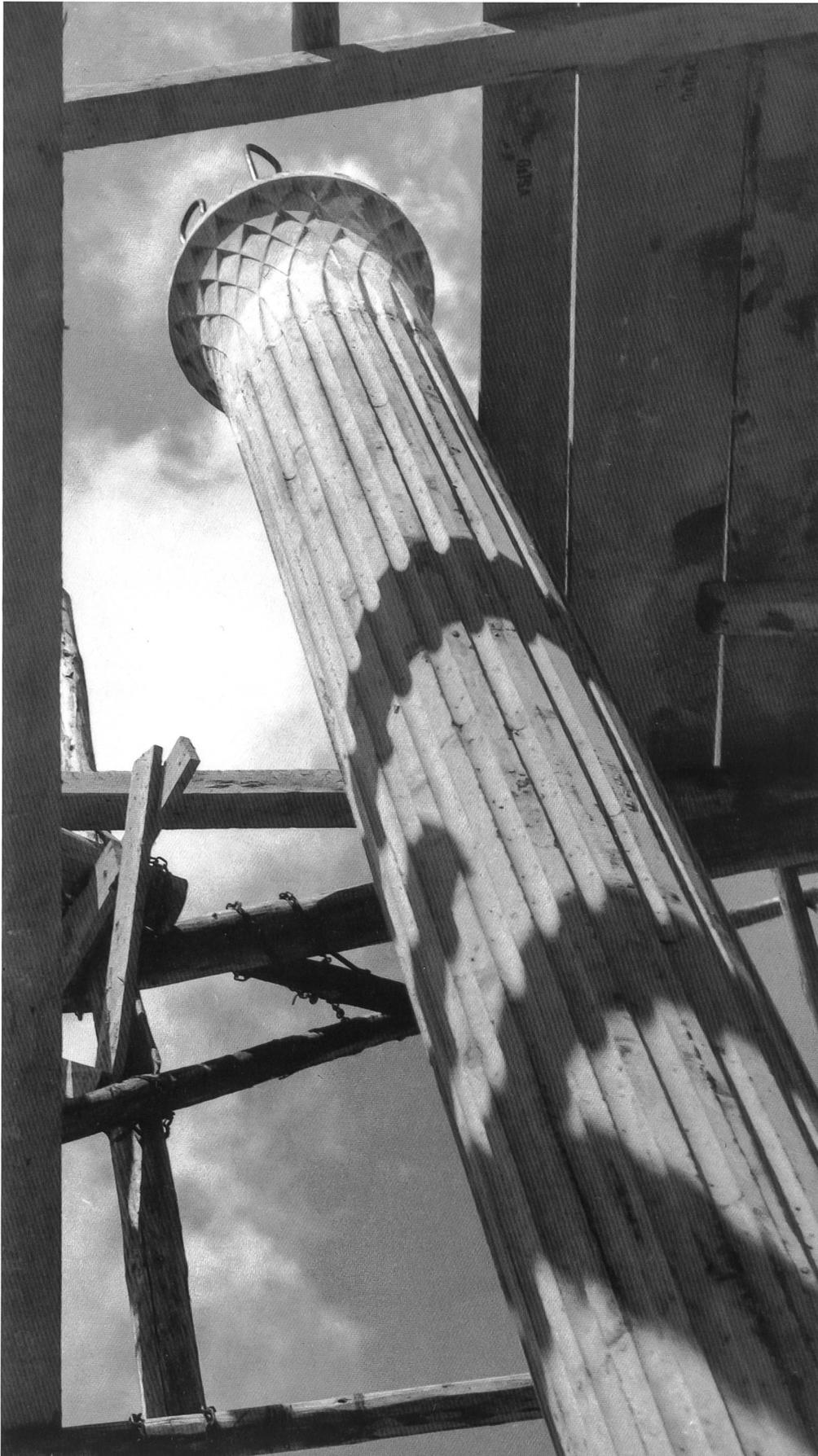
L'une des colonnes supportant l'anneau de béton de la coupole. – «L'architecture, c'est l'art de faire chanter le support» (Auguste Perret). La colonne en béton brut de décoffrage renvoie invariablement à l'Antiquité, avec ses cannelures terminées en corolle, lointain écho des chapiteaux papyrifomes. Elle s'inspire du modèle créé par Auguste Perret pour le Musée des Travaux publics de Paris (1936-1946).
