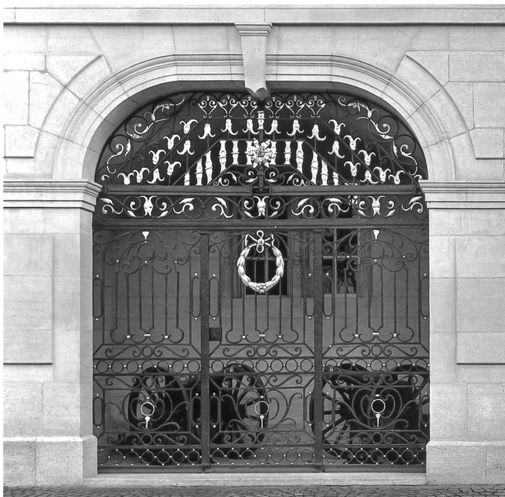
Fig. 85 Grille de l'arcade principale du grand escalier, exécutée en 1776 par le serrurier d'Etat Georg Heinrich Haller, en intégrant des éléments de 1660-1680 (dans la lunette), fer forgé, partiellement doré et argenté, 360 x 315 cm. – Proposée par Raoul Blanchard, l'attribution des grilles des trois arcades à ce serrurier est renforcée par les mentions inédites du paiement de ses travaux effectués en 1775-1776, soit 325 écus, somme importante qui ne peut concerner uniquement son intervention à l'intérieur du bâtiment. La transformation des grilles fut entreprise lors de la réfection de l'escalier en 1776, qui a donné à l'arcade centrale sa forme surbaissée. Les grilles des arcades latérales, dont les panneaux supérieurs dateraient des années 1730-1735, furent aussi complétées en 1776. En 1939, les grilles durent être modifiées suite à un changement de niveau de la place, tandis que la polychromie actuelle, correspondant vraisemblablement à celle de la fin du XVIII e siècle, fut renouvelée en 1958. Derrière la grille, deux canons de 1848.
