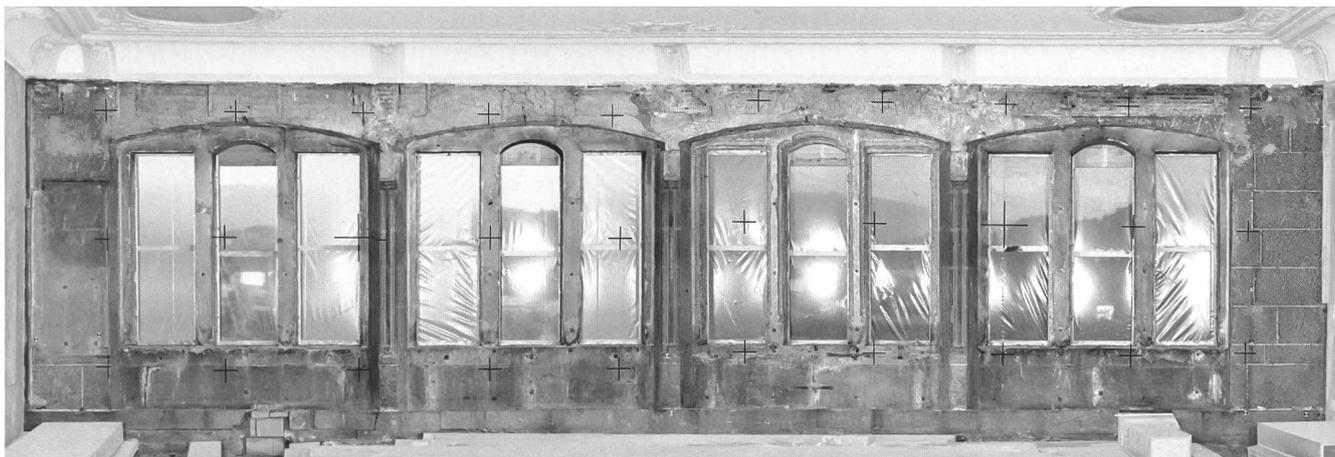
Fig. 5 Orthophoto de la façade sud sans lambris. Le ressaut horizontal situé juste au-dessus des voûtains marque le niveau du plafond du XVI<sup>e</sup> siècle. Les éléments laissés en clair n'ont pas été redressés.
