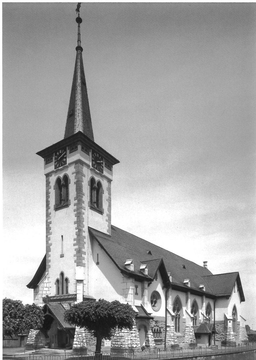
Fig. 11 Vue de l'ouest, avec la tour-porche.
