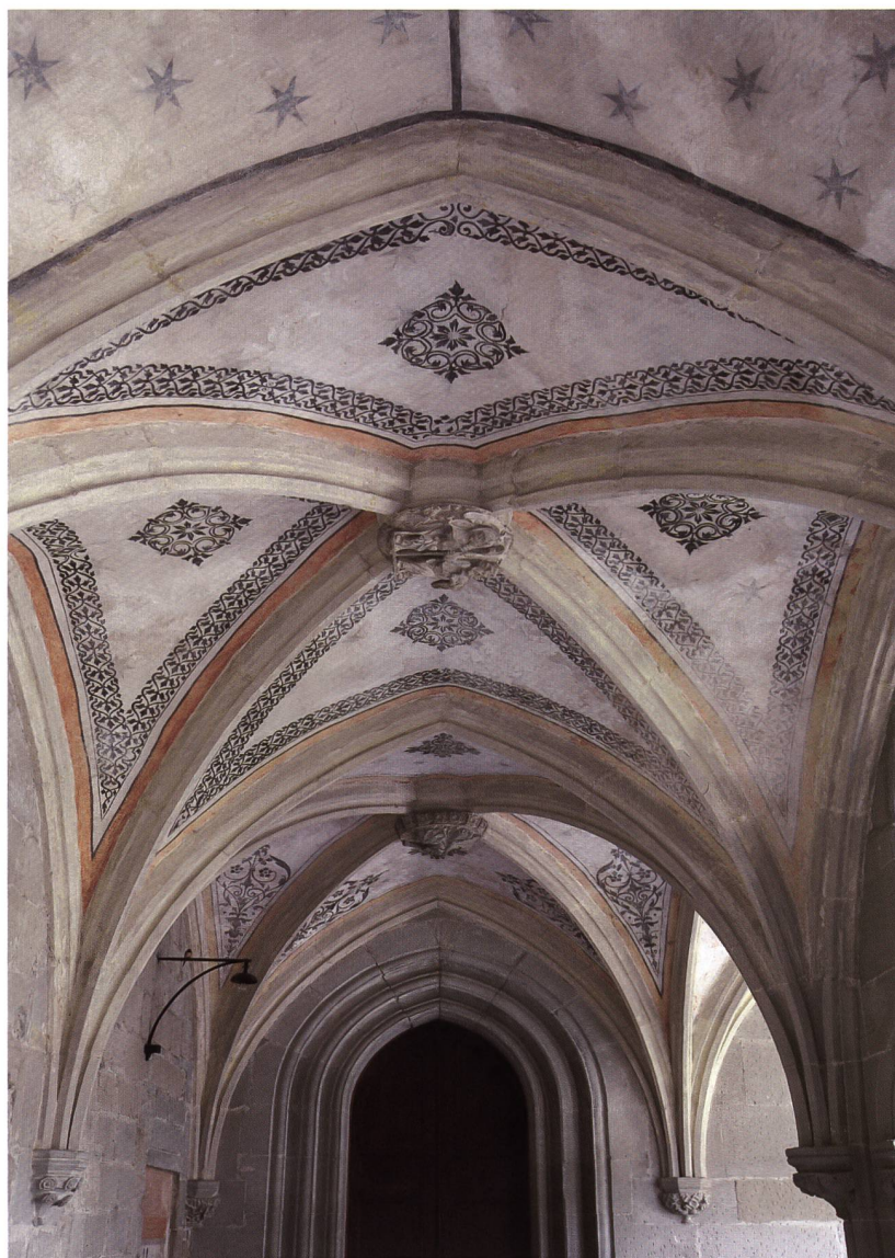
Fig. 54 Travées 18, 19 et 20. La reconstitution entreprise au début du XX e siècle des différents décors peints dans trois travées successives a été conservée et restaurée. Abb. 54 Traveen 18, 19 und 20. Die zu Beginn des 20. Jh. ausgeführte Rekonstruktion je einer andern Fassung in diesen drei Jochen wurde beibehalten und restauriert.
