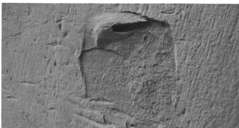
Fig. 90 Détail d'un contrefort en cours de traitement. Les surfaces ont été nettoyées par dépoussiérage et grattage des incrustations, les détachements en plaques ont été consolidés ponctuellement et les bords originaux ont été renforcés par application de solins (colmatages en biseau) à base de poudre de molasse.
