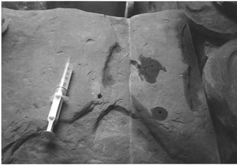
Fig. 112 Quelques tablettes en très mauvais état de conservation ont été remplacées par de nouveaux blocs de molasse, insérés entre les parties anciennes. Ces blocs n'ont pas été vieilliss artificiellement, pour bien laisser l'intervention visible.
