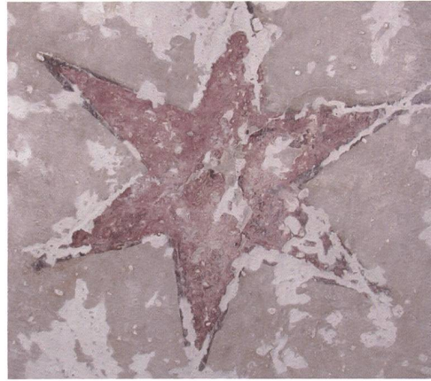
Fig. 87 Voûtain de la travée 23; étoile rouge avec incisions dans l'enduit dessinant son contour. Dans ce cas, des traces de noir sont visibles sur les bords de l'étoile, témoignant de la présence probable d'une feuille métallique, par exemple de l'argent, pour créer un effet étincelant.
