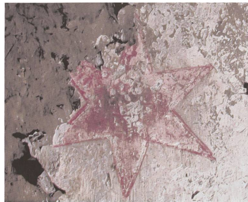
Fig. 88 Cathédrale de Fribourg, collatéral sud, voûte de la travée 5; étoile semblable à celles d'Hauterive, aux contours incisés dans le mortier et présentant une tache noirâtre au centre. Comme pour l'architecture et la sculpture, on peut constater un lien entre ces deux chantiers contemporains.
