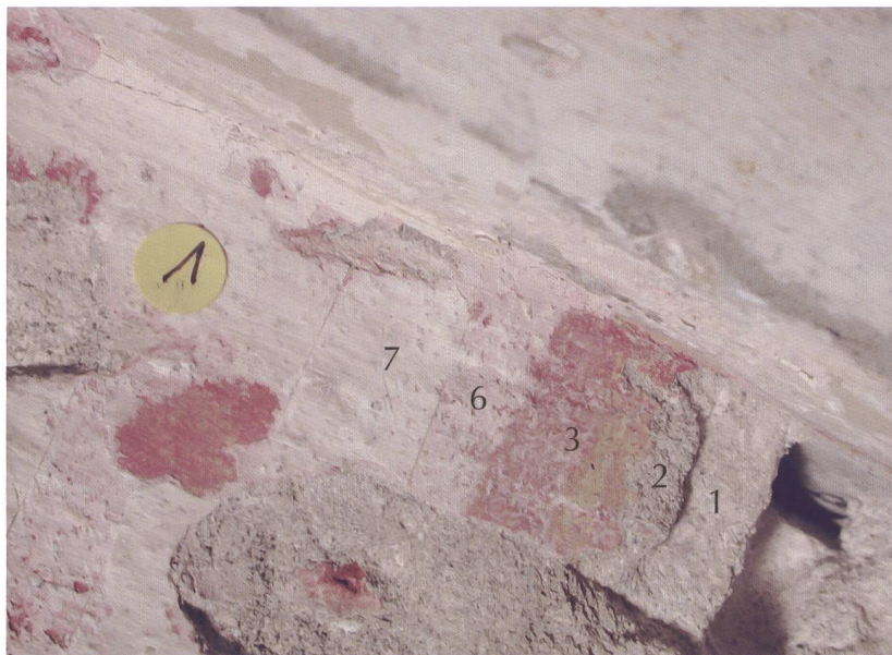
Fig. 81 Travée 26, mur est; sondages avec fiche descriptive.
