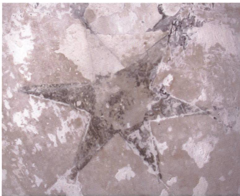
Fig. 86 Voûtain de la travée 17; étoile verte, probablement bleue à l'origine, avec, au cœur de l'étoile, un cercle avec des traces de noir, qui témoigne de la présence probable d'une feuille métallique (par exemple de l'argent) ou bien d'un élément en relief aujourd'hui disparu.
