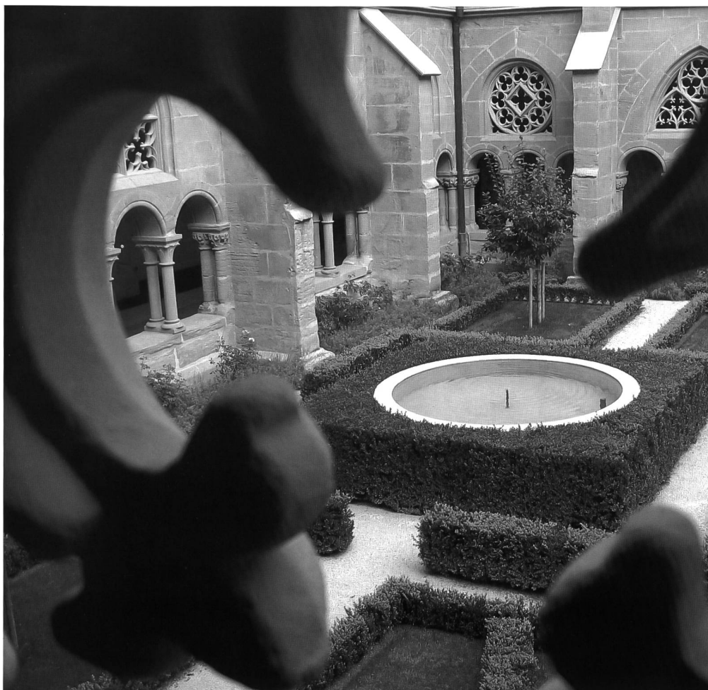
Fig. 12 Vue insolite sur le préau.
