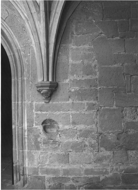
Fig. 30 Vestiges de l'ouverture, murée, de l'ancien accès au cloître roman à travers son aile occidentale. Abb. 30 Reste des vermauerteten ursprünglichen Tors zum romanischen Kreuzgang durch dessen Westflügel.
