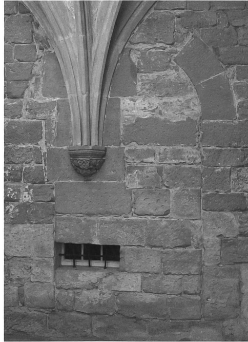
Fig. 31 Vestiges de l'ouverture, murée, de l'ancien accès au réfectoire des convers depuis la galerie occidentale. Abb. 31 Reste der vermauerteten ursprünglichen Tür vom Westflügel in das Konversen-Refektorium.
