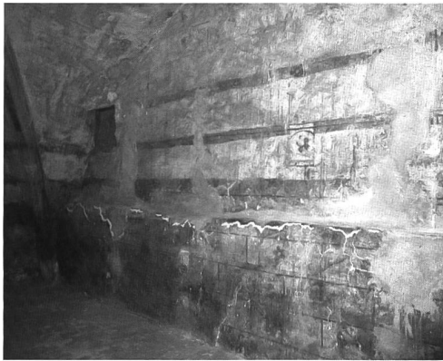
Fig. 40 Ressaut de maçonnerie du mur est de l'aile occidentale, époque romane. Abb. 40 Rücksprung in der romanischen Ostmauer des Westflügels.
