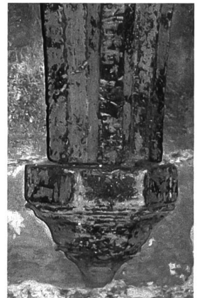
Fig. 43 et 44 Console et nervures des voûtes de la salle sud (cellier, autrefois considéré «latrines des convers»), 1320-1330. Abb. 43 u. 44 Ansatz des Gewölbes im südlichen Raum des Westflügels (ebenerdiger Keller, vormals Konversen-Latrinen genannt), 1320/30.
