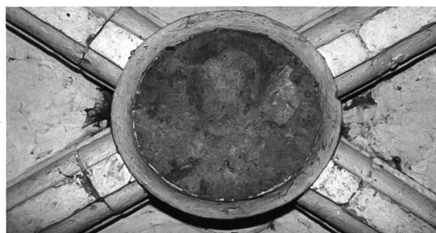
Fig. 46 Clef de voûte de la grande salle, 1320-1330. Abb. 46 Schlussstein im grossen Saal, 1320-1330.
