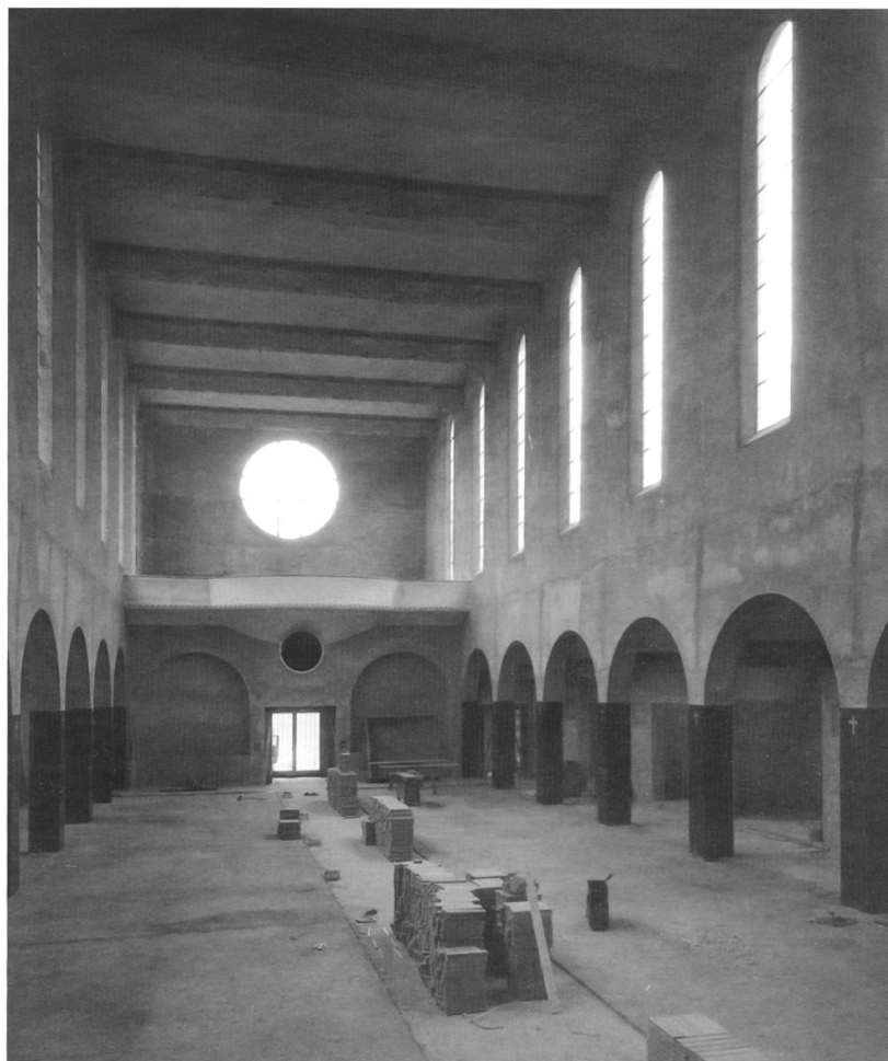
Fig. 48 Vue intérieure en 1930, avant la pose des parquets sous les bancs. En l'absence de chapiteaux, le revêtement des piles en marbre noir de St-Triphon asseoit l'élévation et accentue les lignes de fuite sous les archivoltes (ASBC, photothèque, Fonds Reiners).
