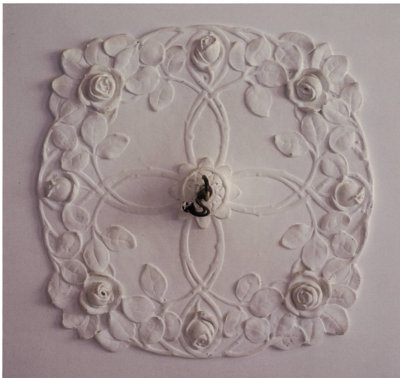
Fig. 5 Rosace en staff au plafond de l'ancienne salle à manger.
