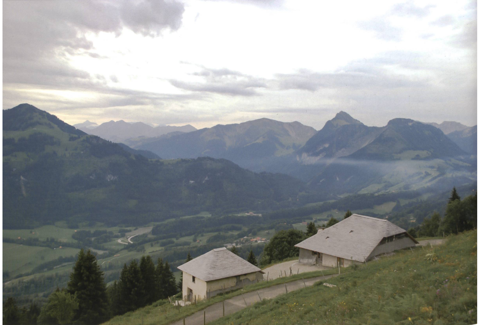
Fig. 2 Le chalet construit en 1726 et le saloir de Pra Chablais, au-dessus des Sciernes d'Albeuve, réfection de la toiture, 2009, Renaud Moura.
