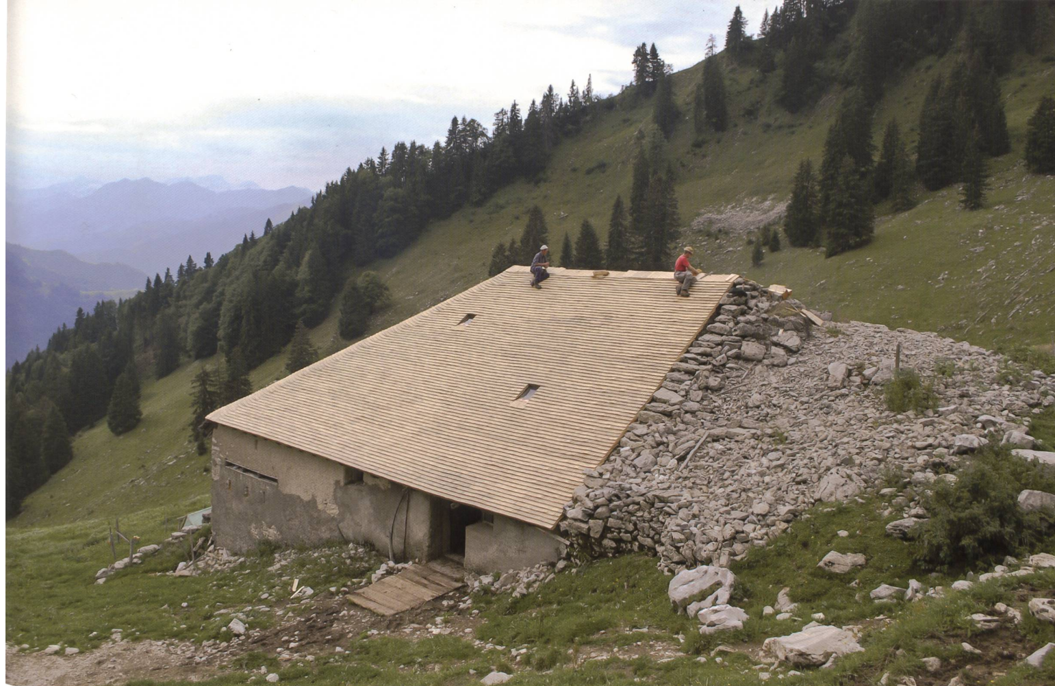
Fig. 5 Vue de l'arrière du chalet de la Grande Ecosalla avec son talus pare-avalanche permettant aux coulées de neige de glisser le long des pans.
