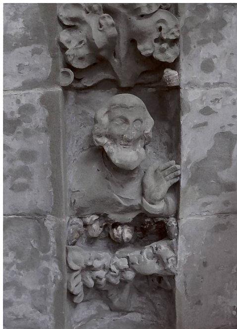
Fig. 9 Portail sud, détail d'une voussure avec tête de prophète en cours de remodelage, 2015.
