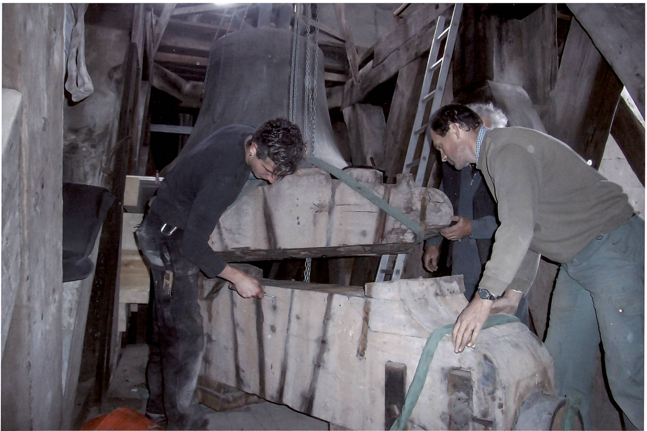
Fig. 13 Dépose du joug de la cloche de Sion ou Sainte-Marie: la partie inférieure date du XV e siècle, la partie supérieure de 1841.
