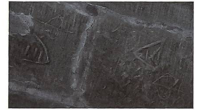
Abb. 39 Die aus sphärischen Dreiecken gebildeten Trompen stellen hohe Anforderungen an den Steinschnitt und den Versatz. Daher die zahlreichen und mehrteiligen Versatzzeichen.
