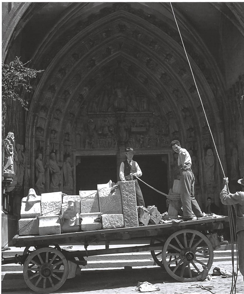
Fig. 42 Die Werkstücke für die 1928 begonnene Turmrestaurierung werden auf einem Brückenwagen herbeigeschafft. Der Kantonsarchitekt Edmond Lateltin als ein moderner Dombaumeister legt mit einem Arbeiter Hand an. Im Mittelalter sah es wohl ähnlich aus. Eilt es, weil ein Feiertag bevorsteht? Die Bäumchen vor dem Portal lassen dies vermuten.
