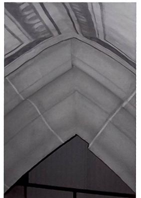
Abb. 41 Bogensteine wurden auf Vorrat gearbeitet. Bei den Gurtbögen der Seitenschiffe passten sie nach zwischenzeitlichen Setzungserscheinungen teilweise nicht mehr, so dass einige der Bögen mit leichtem Versatz ausgeführt werden mussten.
