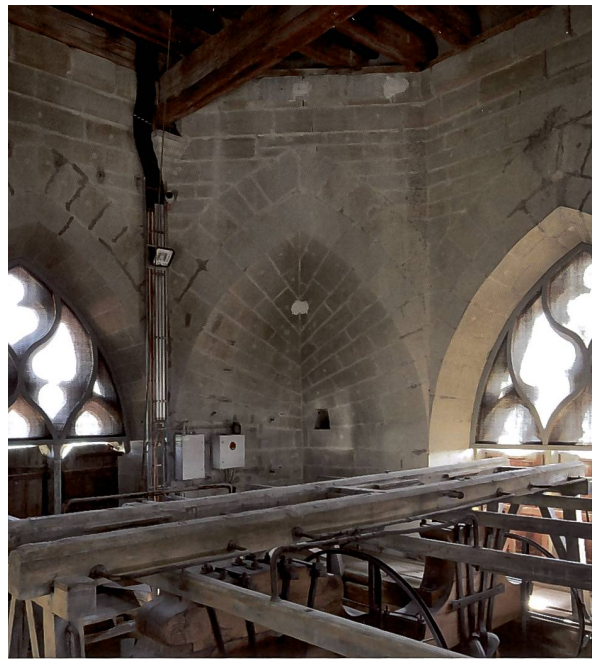
Abb. 23 Glockenturm; der Übergang vom Quadrat zum Achteck wird durch Trompen vermittelt.
