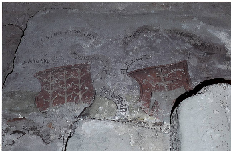
Abb. 71 Block mit Wappen und Grabinschriften der Margaretha List (†1548) und der Elisabeth Python, Ehefrauen des Wilhelm von Praroman. In Zweitverwendung sichtbar im Dachraum stammt dieser Block aus dem unteren Bereich der Südwand, wo er anlässlich der Verlängerung der Fenster ausgebaut wurde.
