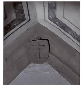
Abb. 62 Falck-Kapelle, Meisterzeichen von Hans Felder dem Jüngeren im Scheitel des Schildbogens auf der Ostseite.
