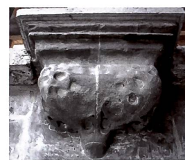
Abb. 103 Neugotische Konsole unter der Zinnenreihe von 1844, Zustand vor der Restaurierung 2016.
