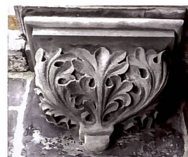
Abb. 105 Neugotische Konsole, restauriert nach Befund und alten Aufnahmen.
