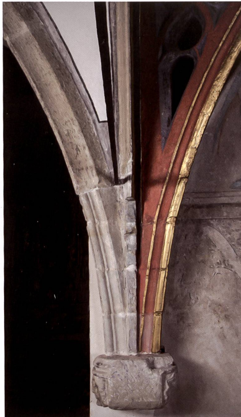
Fig. 13 Départ des nervures de la chapelle sud et de la travée centrale du jubé, avec les quatre pièces monolithes formant le tas de charge, entre 1370-1385.
