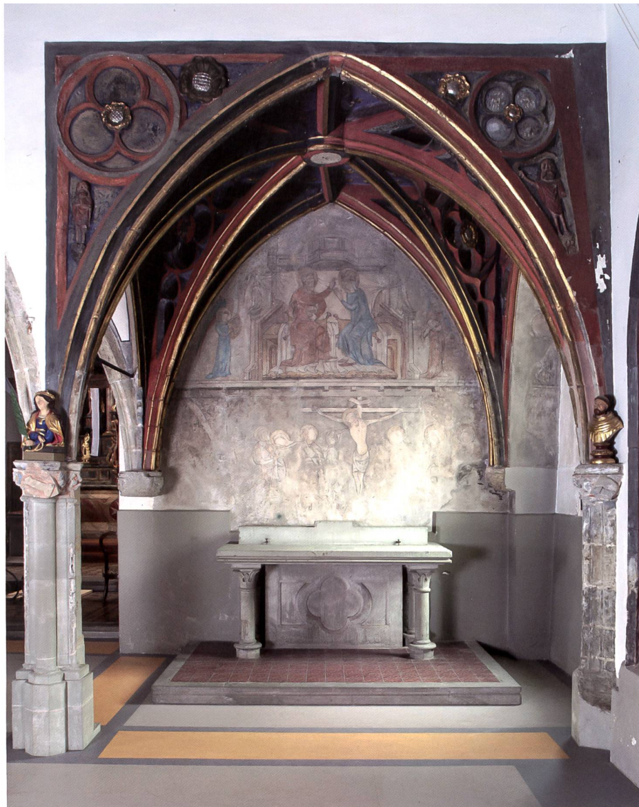
Fig. 17 La travée sud du jubé, probablement la chapelle funéraire du commandeur Wilhelm Huser (1364-1385), avec son décor de remplages aveugles et ses arcs diaphragmes, entre 1370-1385.
