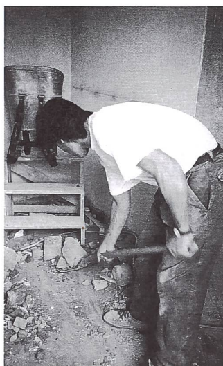
Abb. 10a: Arbeitsabläufe beim Schutttransport mit hohen Rumpf-, Hüft- und Kniebelastungen. Das Schaufeln mit zu geringer Wirbelsäulenstabilisation.
