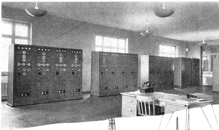
Brown Boveri Sender für den Flugsicherungsdienst in der Sendestation Walthikon bei Zürich
