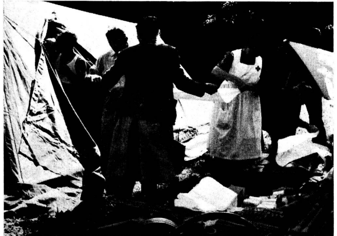
Der Militärsanitätsverein beim Aufbau des Operationszeltes
