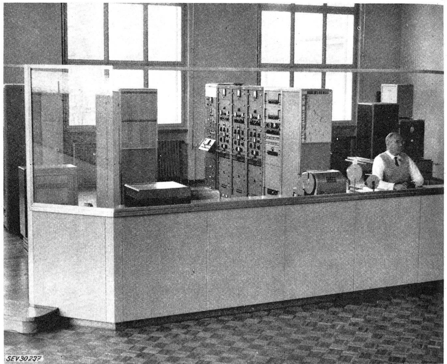
Fig. 17: Kontrollkabine (Sendestation Münchenbuchsee)
