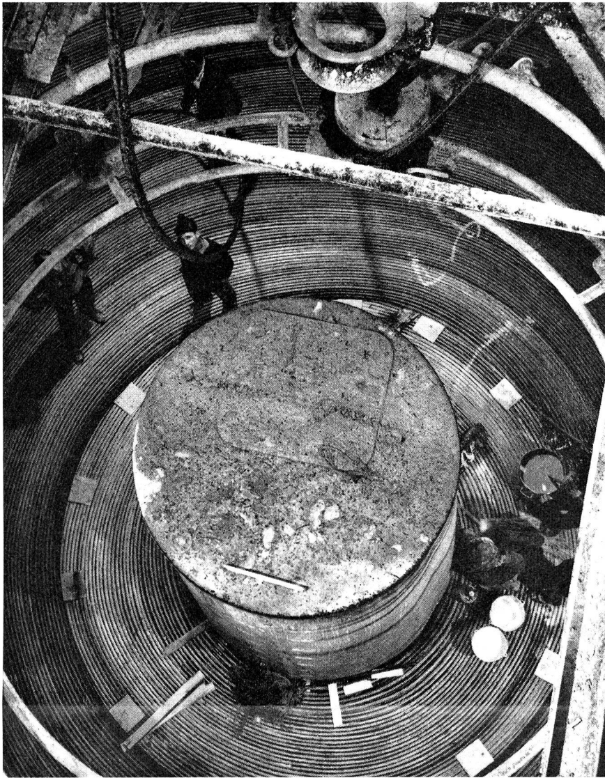
Fig. 2: Einer der drei grossen Laderäume mit 15 m \Phi mit dem Überseekabel auf dem Kabellegedampfer «Monarch».
