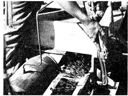
Lostrennung der Brücke vor der Verschiebung
