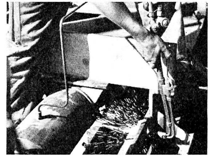
Lostrennung der Brücke vor der Verschiebung
