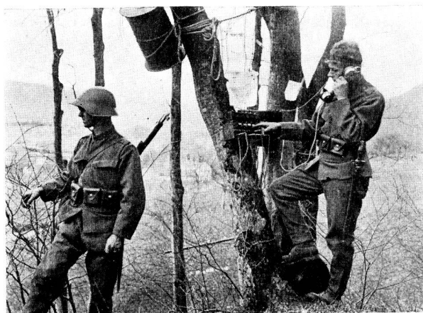
Abb. 25. Zentrale mit Vermittlerkästchen in feldmässigem Einsatz.
