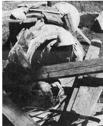
Sorgfältige Trümmerberäumung über einem Verschütteten nach Überwindung der mit verschiedenen Trümmern versperrten Fuchsröhre.
