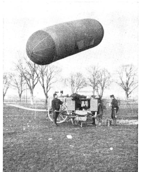
Funkversuche mit der Ballonantenne 1905
