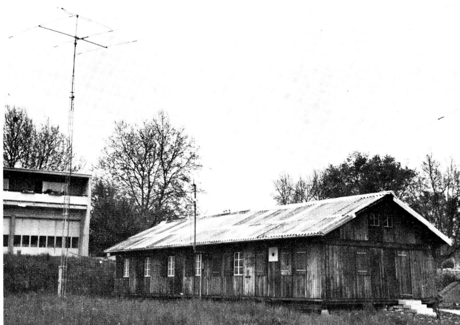
Bild 1: Das neue Funklokal der EVU-Sektion Zürcher Oberland/Uster. Die Militärbaracke wurde vom Eidg. Militärdepartement leihweise überlassen. Links im Bild ist der Mast mit den Richtstrahlantennen sichtbar.
