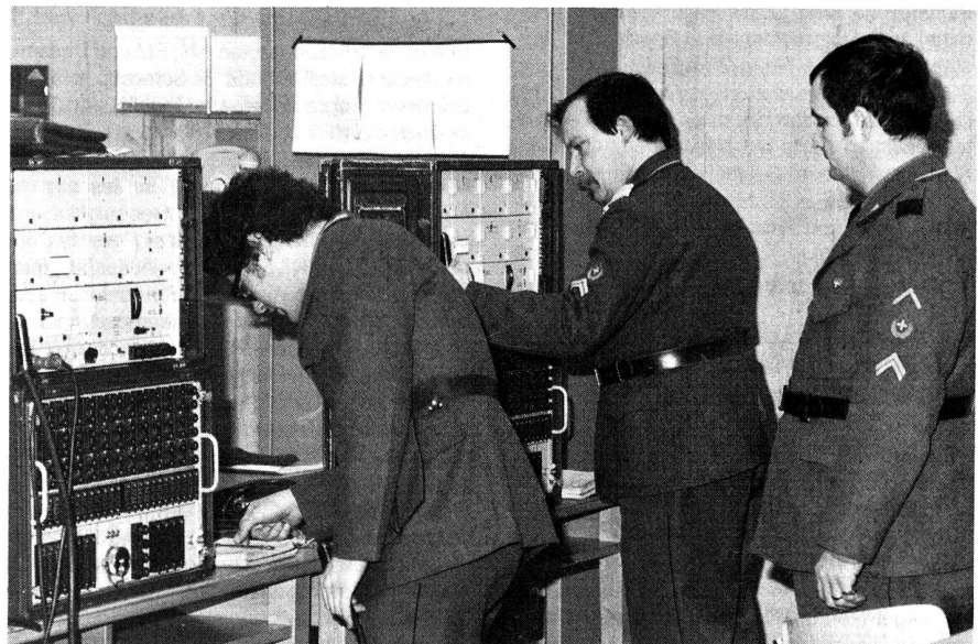
Unter prüfendem Blick von Adj Uof Balz Schürch (rechts im Bild) erstellen die Kursteilnehmer anhand der Checklist die Verbindungsbereitschaft zwischen zwei Mehrkanalteilen MK 5/4.
