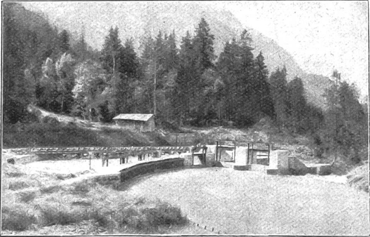
Wehranlage des Elektrizitätswerkes Kandergrund. Das Wasser wird von hier aus durch einen ca. 4200 Meter langen Zuleitungsstollen ins Wasserschloss geführt.
