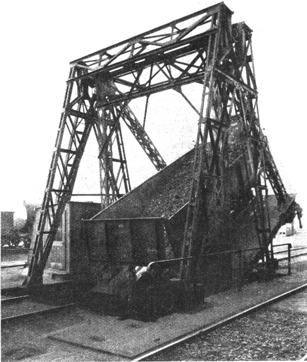
Der Wagenkipper, eine Vorrichtung, welche das zeitraubende Ausladen mit Schaufeln überflüssig macht. Solche Apparate sind im Gebrauch bei Gasfabriken, zum Entleeren der Kohlenwagen.
