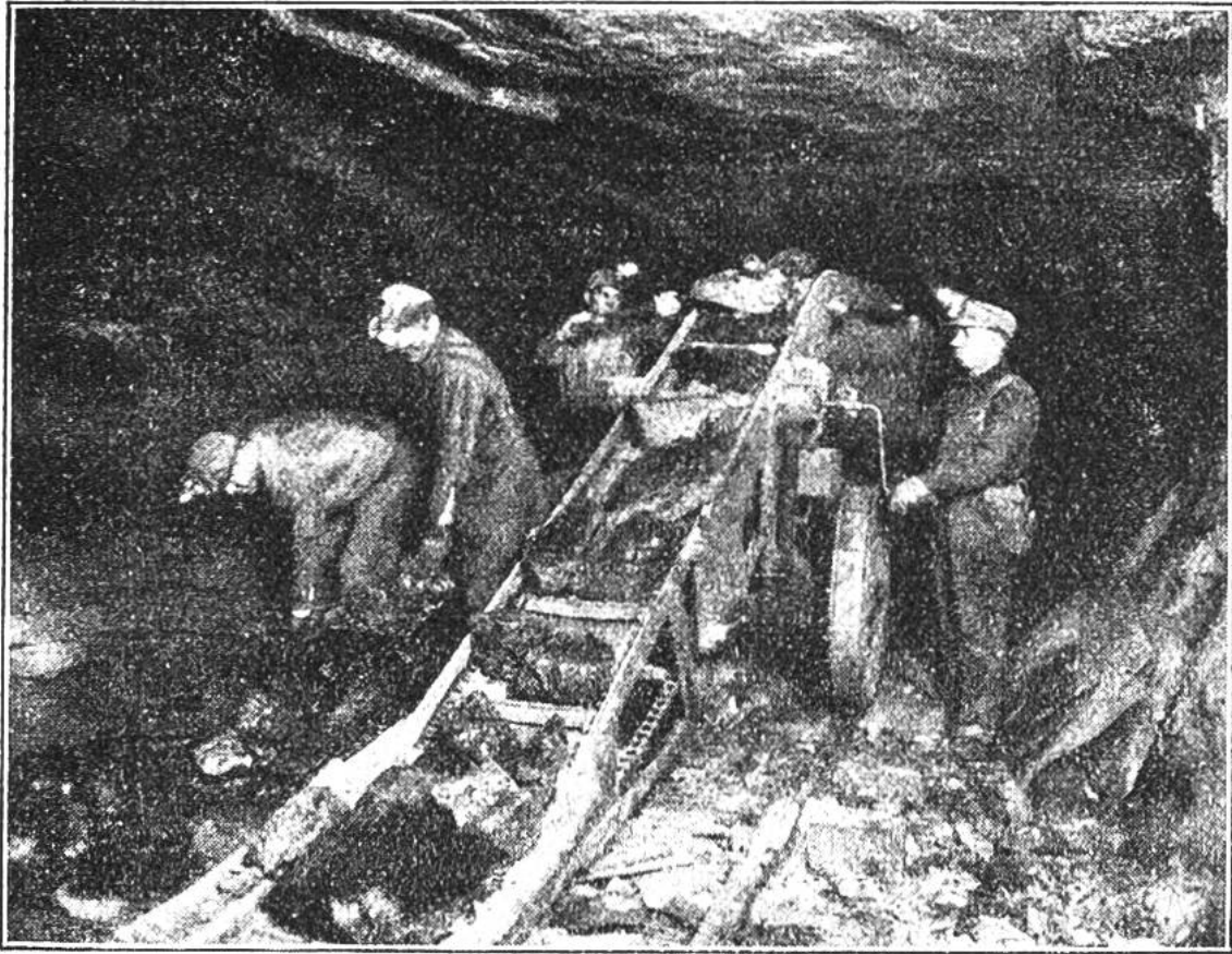
Ein Grubenwagen wird automatisch von einer Art laufenden Bands mit Kohle beladen. Aufnahme in einem Bergwerk von Pennsylvania.
