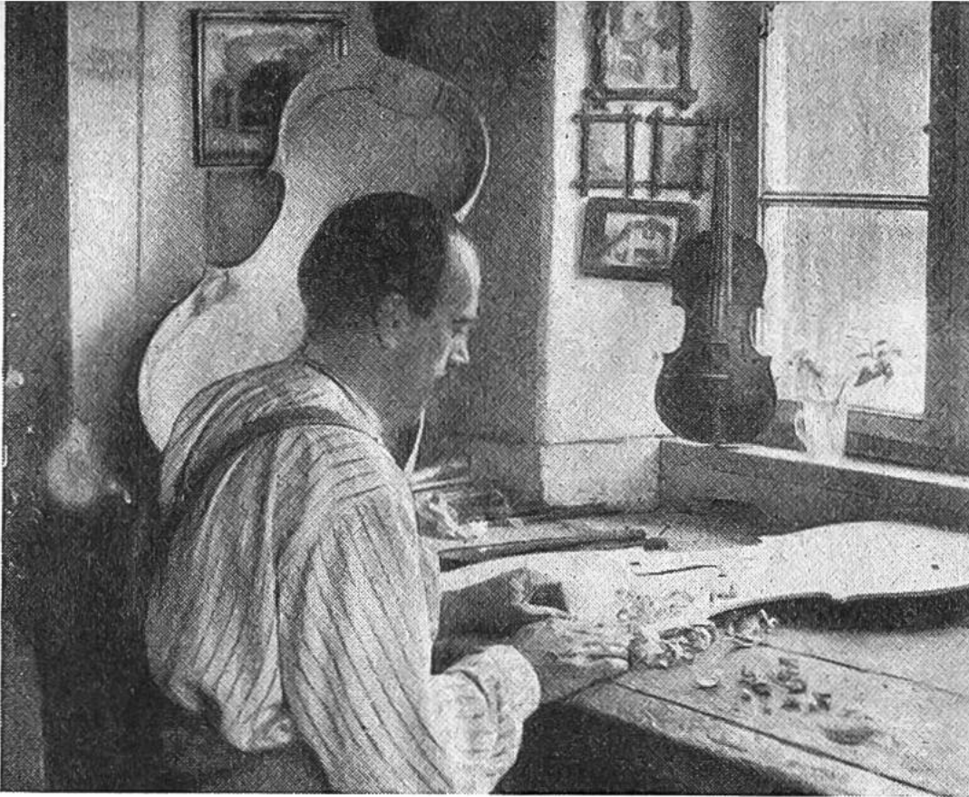
M i t t e n w a l d e r G e i g e n - u n d C e l l o - m a c h e r . H i e r w e r d e n d i e D e c k e l a u s g e h ö h l t .
