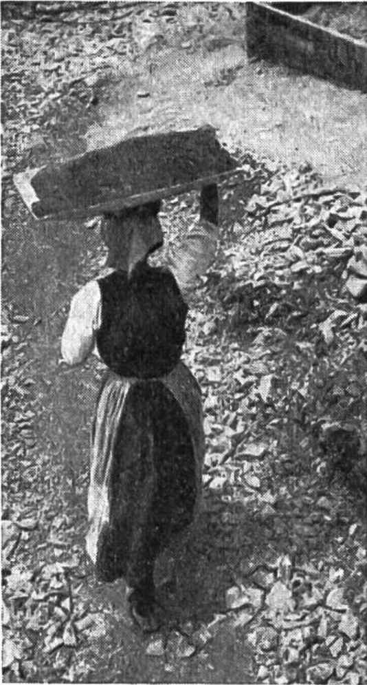
Ein Haus wird gebaut. Die Frau hilft mit, trägt Sand herbei. . .
