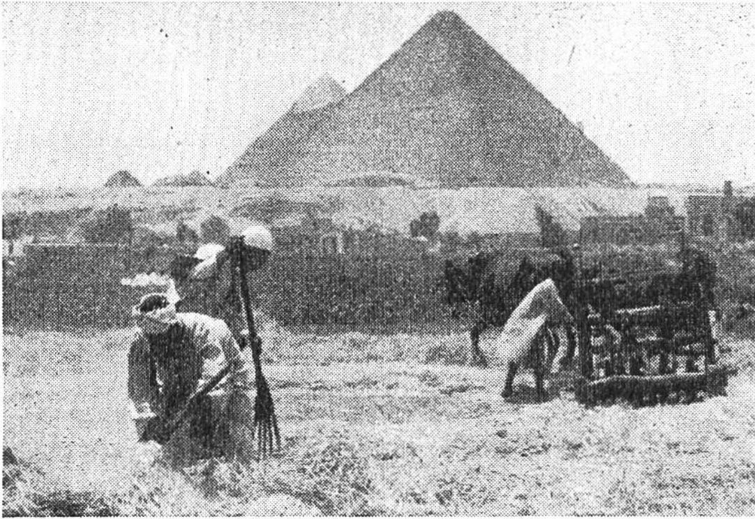
Dreitausendjährig wie der Hakenpflug ist der Dreschschlitten. Geschärfte Eisenscheiben auf drehbarer Walze zerkleinern Halme und Ähren; dann erst wird das Getreide durch Worfeln gereinigt.
