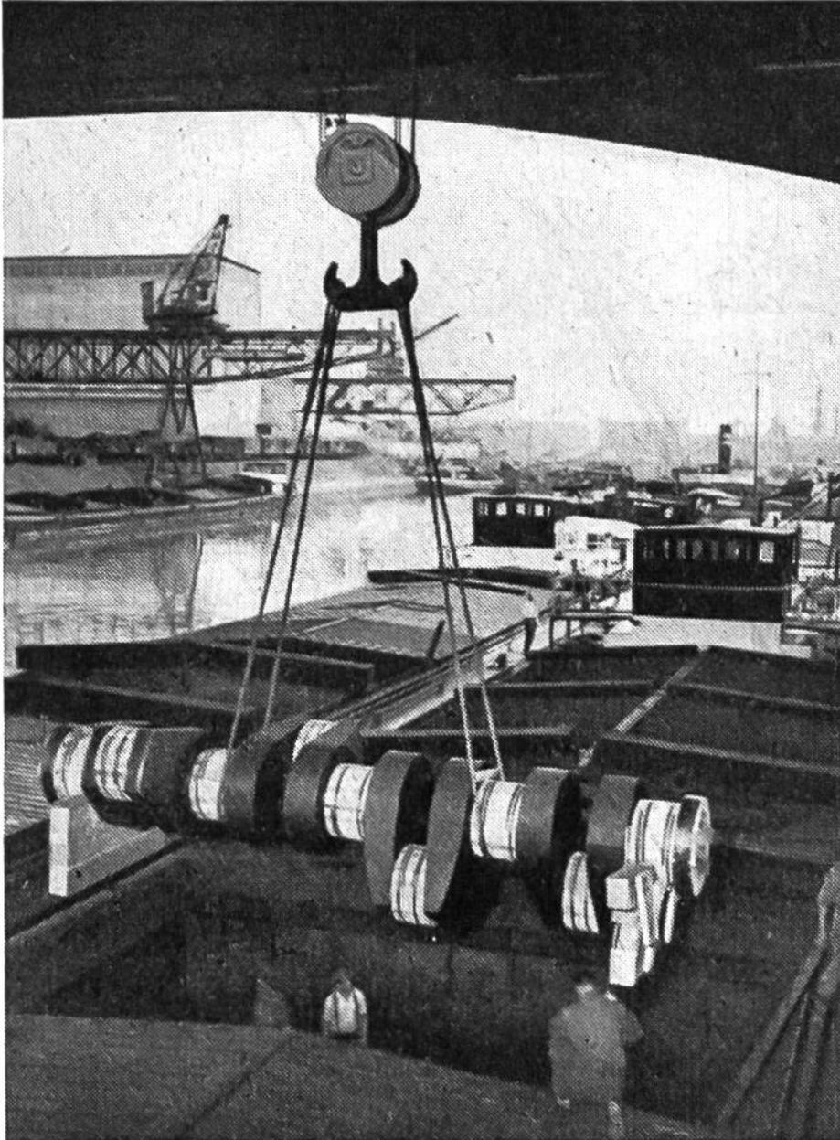
Mit einem Schwergutkran von 65 Tonnen Tragkraft wird die Kurbelwelle für den Dieselmotor eines Seeschiffes zum Transport in einen Meerhafen verladen. Die billige Wasserfracht trägt zur Konkurrenzfähigkeit der schweizerischen Maschinenindustrie wesentlich bei.
