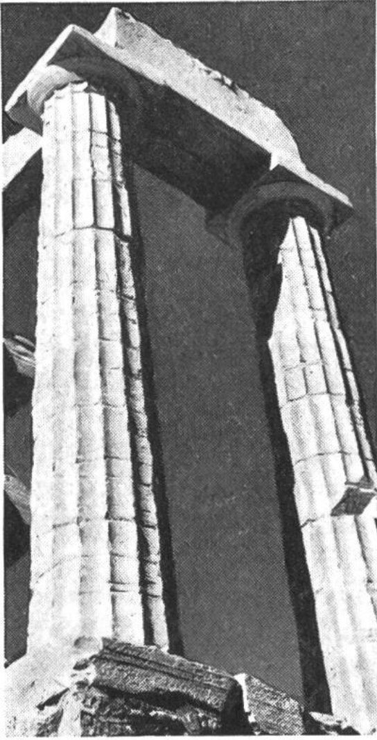
Die Säulen des dorischen Poseidontempels auf Kap Sunion an der Südspitze Attikas bestehen aus grobkörnigem, weissem, heute sehr abgeschliffenem Marmor und weisen 16 Kannelüren auf.
