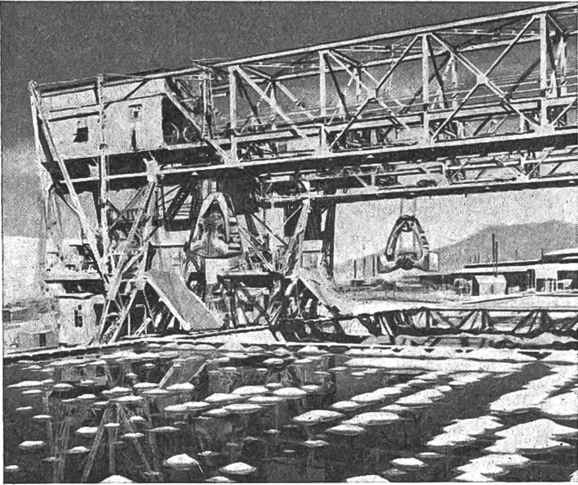
Hüttenanlage, in welcher das Kupfer im nassen Verfahren durch Lösung mit Säuren aus dem Erz entfernt wird.
