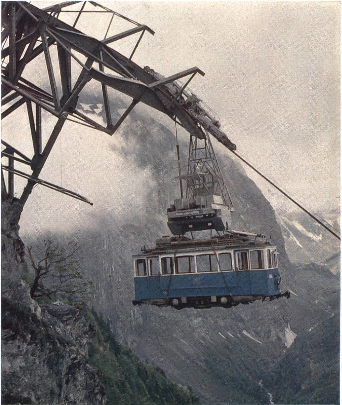
Schwerlastseilbahn Tierfehd (Kraftwerke Linth-Limmern) transportiert einen Zürcher Tramtriebwagen auf die Höhe der Baustelle.
