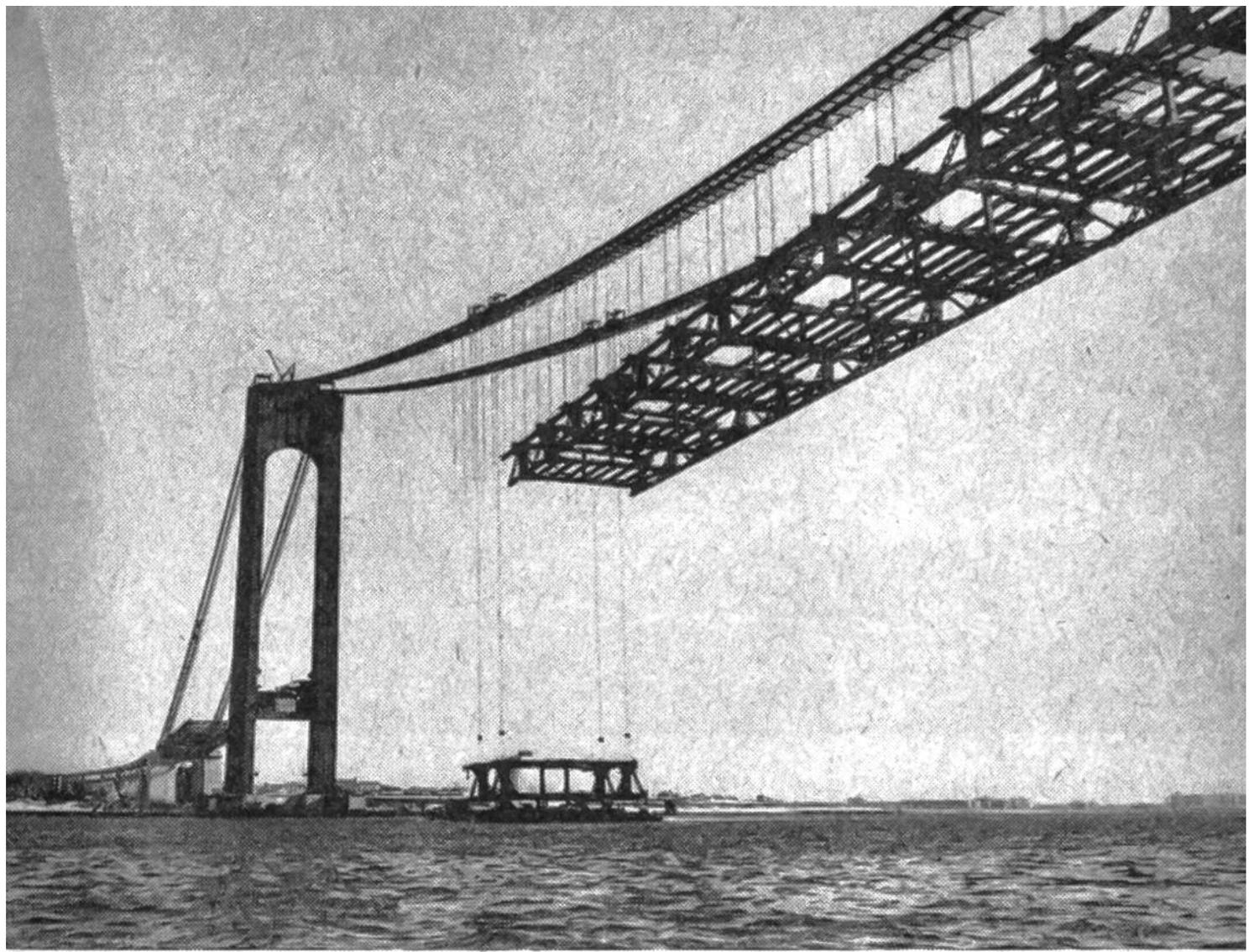
Die Fahrbahn setzt sich aus einzelnen Abschnitten zusammen. Hier wird eben ein Stück der obern Fahrbahn gehisst und an die «Wäscheleinen» gehängt.
