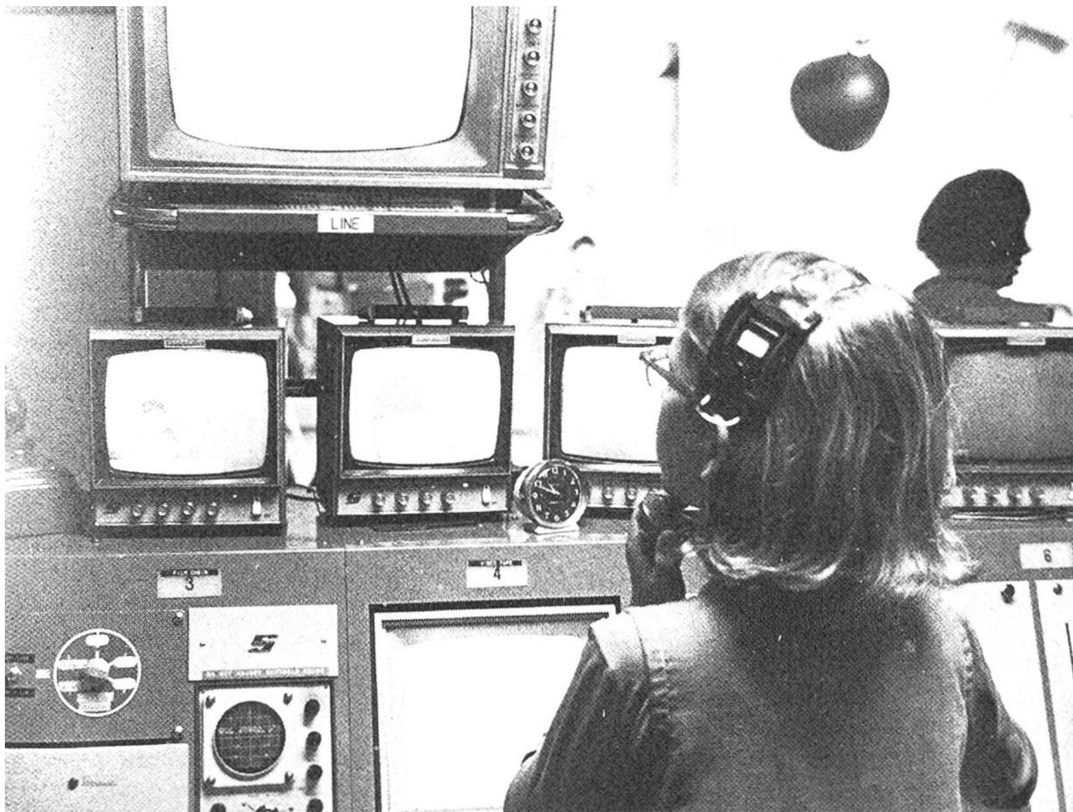
*Eine Schülerin überwacht die Sendung im Kontrollraum, sie ist durch Kopfhörer und Mikrofon mit der Aufnahmeequipe verbunden. Jede Kameraaufnahme erscheint am entsprechenden Monitor, am Mischpult wird das Bild- und Tonmaterial zur Sendung «gemischt».*
