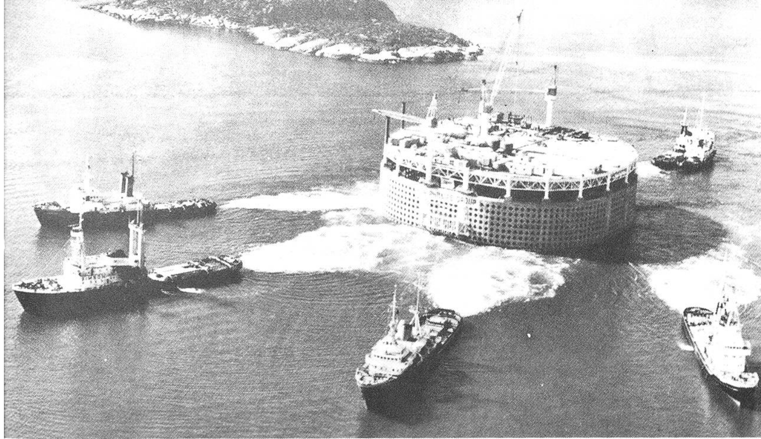
Die Betonelemente der Wellenbrecherwand um das 90 Meter hohe Ölreservoir, das nach dem Nordsee-Ölfeld Ekofisk geschleppt wird, wurden mit Araldit zusammengeklebt.
