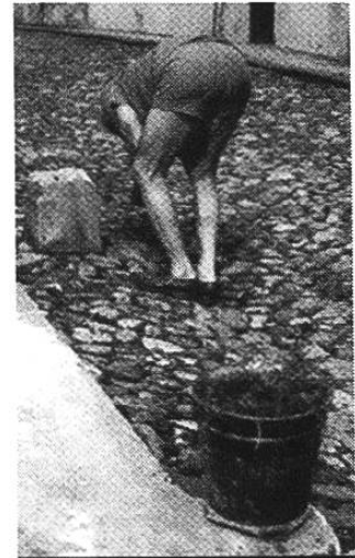
Wo Strassen gejätet werden - Bild aus Hermannstadt.
