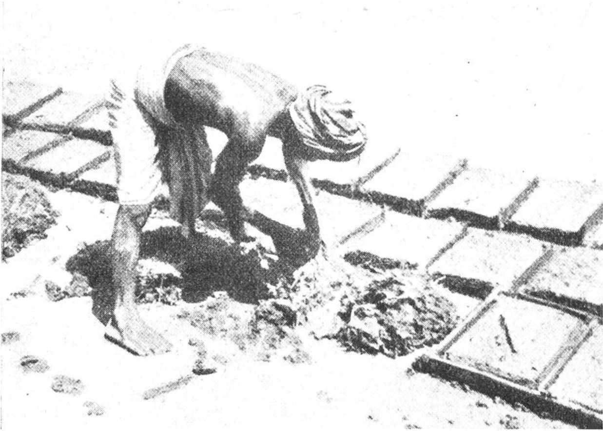
Ein arabischer Maurer verfertigt mit Stroh vermischte Lehmziegel, die, an der Sonne getrocknet, das Baumaterial für die Wolkenkratzer bilden.
