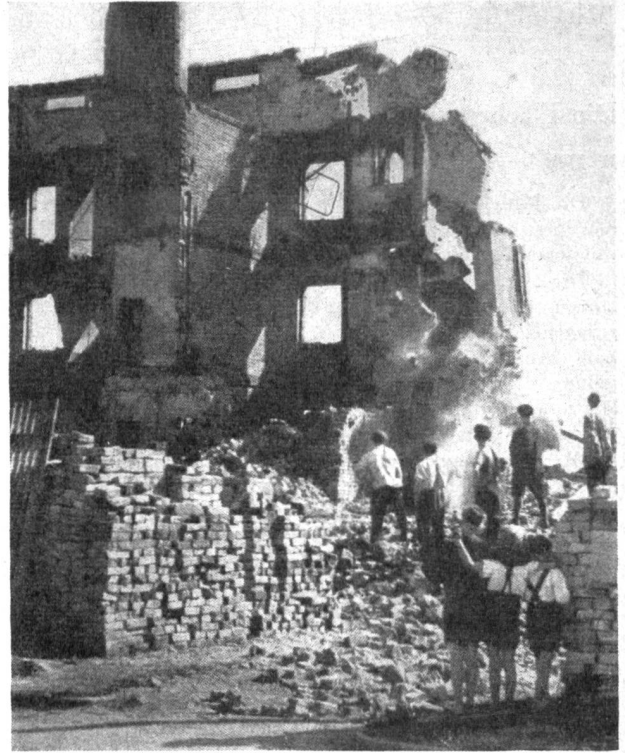
Abb. 1. Backsteine werden aus den Trümmern herausgeholt.
