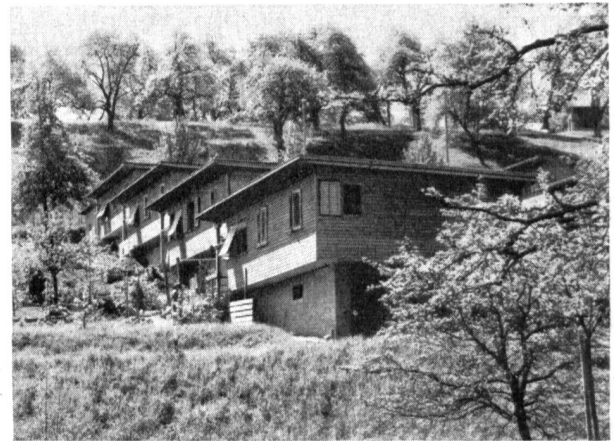
Abb. 2. Ausgeführte Siedlung in der Art des «neuen Bauens».
