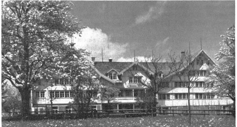
Abb. 1. Ferienhotel aus dem Appenzellerland. (Aus dem Schlussbericht der „Baulichen Sanierung von Hotels und Kurorten“.)
