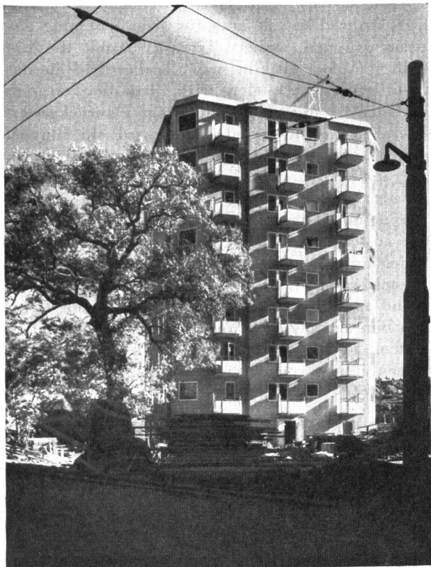
Abb. 2. Punkthauturm auf Danviksklippan bei Stockholm. Neunstöckiger quadratischer Turm. Arch. Backström und Reinius.
