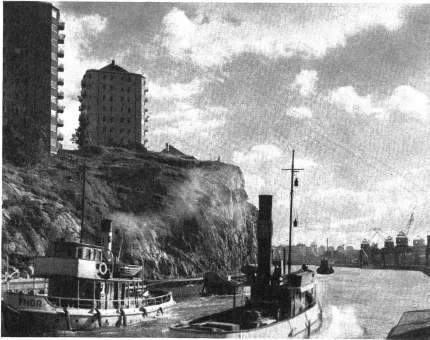
Abb. 1. Punkthäuser auf Danviksklippan in Stockholm. Neun 8–10stöckige quadratische Türme mit stark abgeschrägten Ecken akzentuieren eine durch Sprengungen hervorgehobene, bewaldete Felskuppe an der Peripherie der Stadt. Arch. Backström und Reinius.
