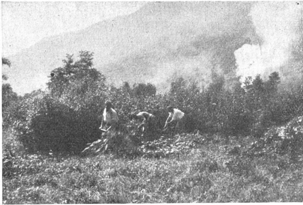
Abb. 2. Rodungsarbeiten in der Magadinoebene.
